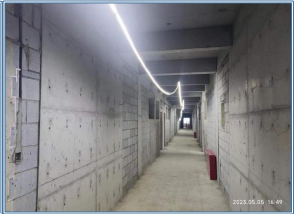
▲二次结构加气混凝土砌砌
