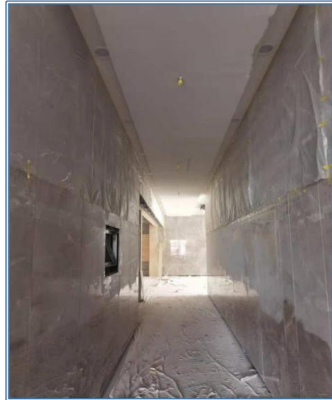
▲ 裙楼干挂石材施工
