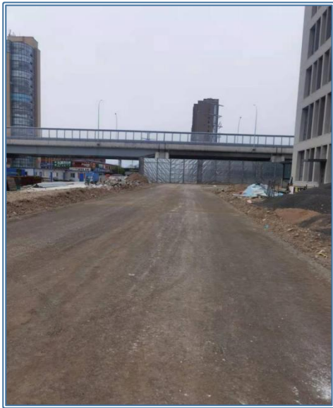
▲ 室外路面基层施工
