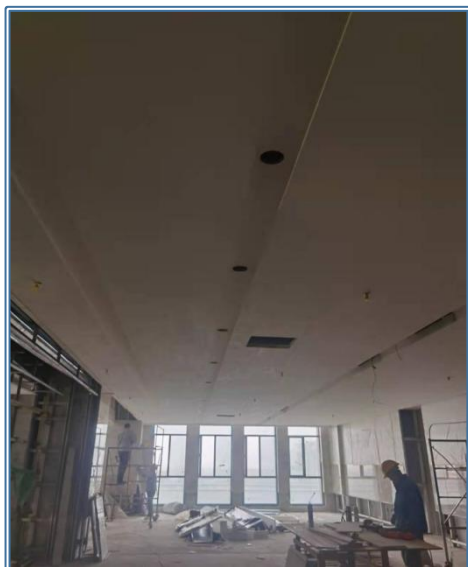
▲ 裙楼铝板施工
