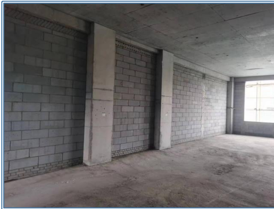
▲二次结构加气混凝土砌砌
